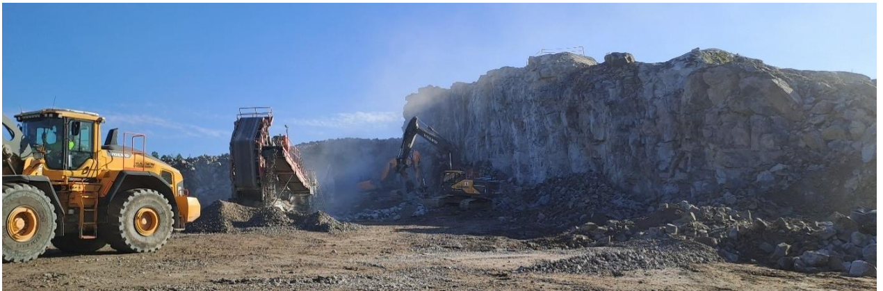
Kuva 2. Kallioseinämän hyödyntäminen murskalaitoksen meluesteenä.
