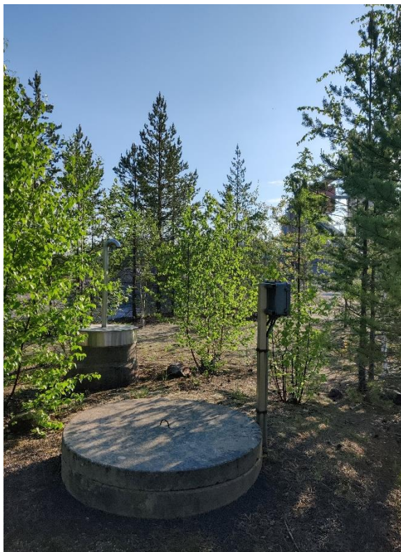
Kuva 1. Käyttövesikaivo, kuvattu 5/2024. Näytteenottokaivo kuvassa taaempi kaivo.
