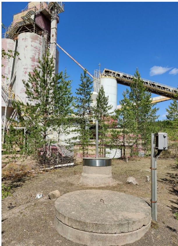
Kuva 1. Käyttövesikaivo, kuvattu 5/2021. Näytteenottokaivo kuvassa taaempi kaivo.
