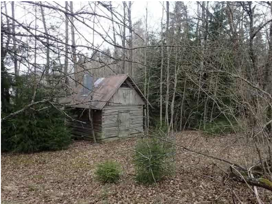
Kuva 12 Syrjämäessä on vielä jäljellä vanhaa rakennuskantaa kohteella 9.
