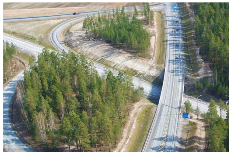
Kuva 41. Valtatie 2 ja 25 risteysalueella on paljon rakennettuja luiskia Porintien (Vt 2) kulkiessa kohtisuoraan Salpausselän läpi. (v. 2017)
