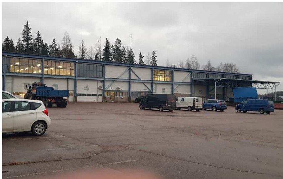
Kunnan varikkokäytössä oleva Vihdin Sähkön rakennuttama teollisuushalli, Asemantien 30
