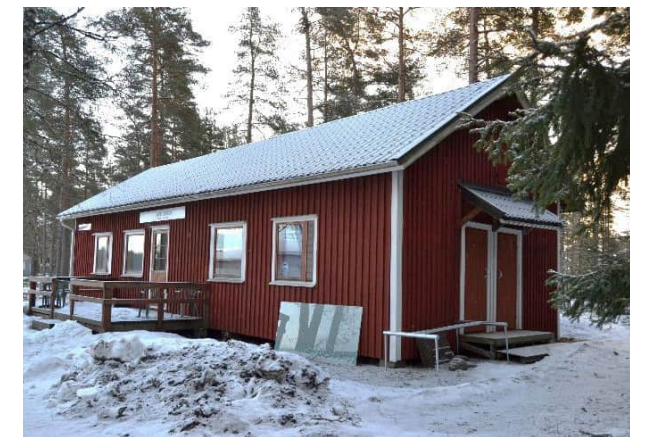
1940 valmistunut lentokentän työparakki. Kuva Heilu Oy 2023
