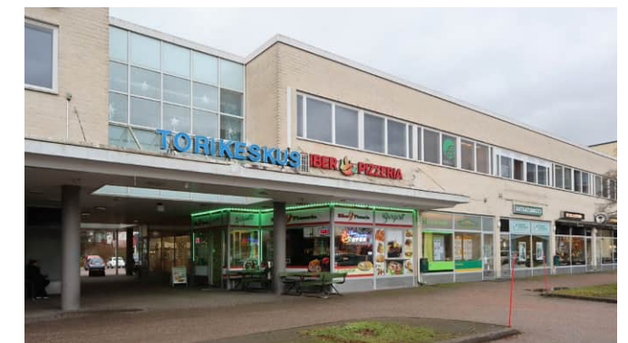
Torin laidalle vuonna 1989 valmistuneessa Torikeskuksen rakennuksessa toistuu alueelle ominainen mittakaava sekä julkisivuissa vaalea kellertävä tiili ja nauhaikkunat.
