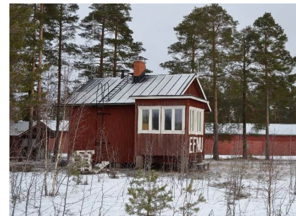
1940 paikkeille valmistunut lennonjohtorakennus. Kuva Heilu Oy 2023
