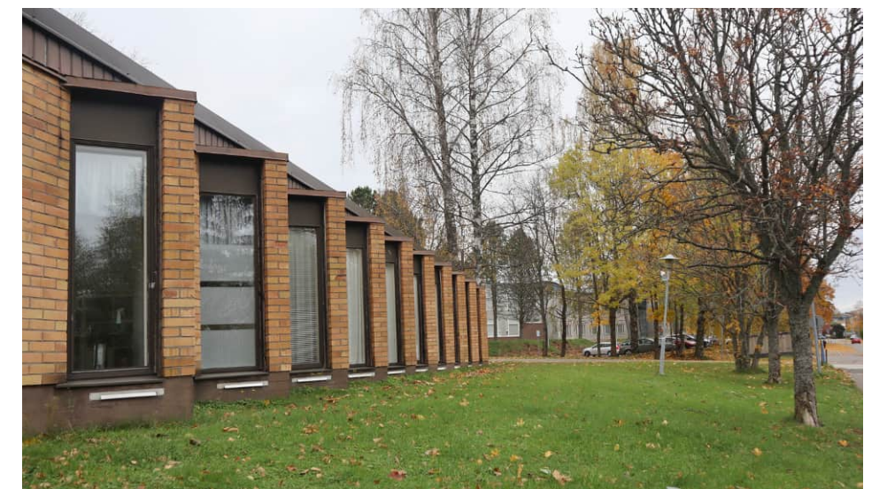
Arkkitehtitoimisto Olli Väänäsen suunnittelema 1977 valmistunut entinen kirjasto-rakennus on nykyään Helluntaiseurakunnan käytössä.
