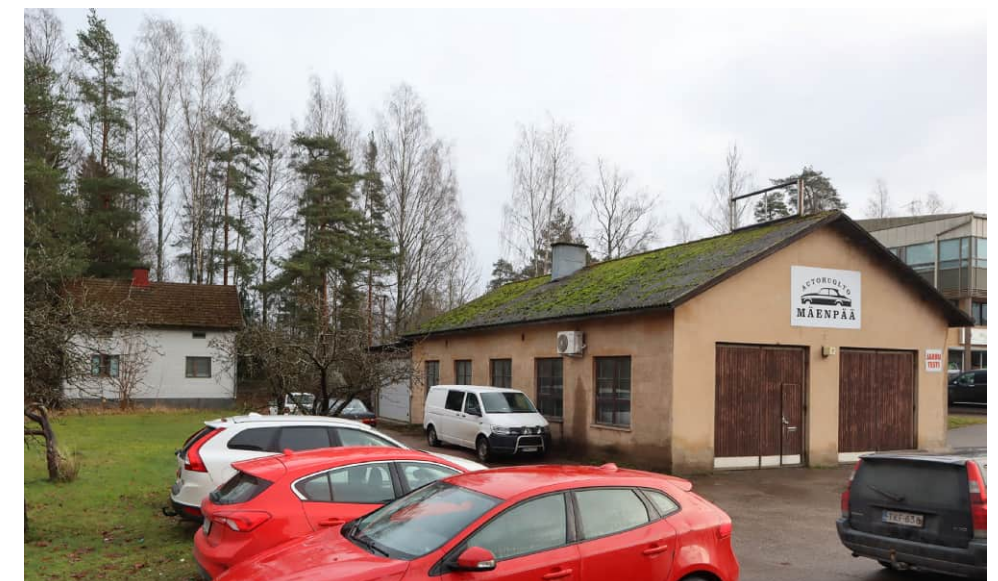
Autokorjaamo ja asuinrakennus 1940-1950-luvuilta Vihdintien varressa
