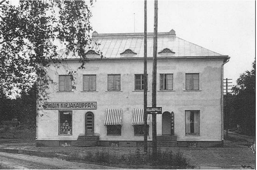
Pilkkuja 1 kohdalle valmistui vuonna 1928 kaksikerroksinen tyyliään 1920-luvun klassismia edustava liiketalo Vanha Eroittaja. Alakerran liikehuoneistoihin asettuivat Nummelan Osuuskassa, Nummelan kirjakauppa ja lyhyttavaraliike. Vuonna 1948 rakennus siirtyi Osuuskalle, joka rakensi Pisteenväylän puoleisen lisäsiiven, jonne tuli pankin tila. Myöhemmin talossa on toiminut mm. Kallen kauppatalo. Tämä Nummelan keskustan vanhin säilynyt kivitalo on useiden muutos- ja laajennusvaiheiden seurauksena ilmeeltään muuttunut, mutta on silti kaupunkikuvassa hyvin tunnusomainen. https://www.nummela.info/
