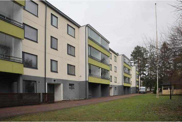
Vain hieman myöhemmin vuonna 1976 toteutettu Ojakkalan-tie 2 kerrostalo edustaa myöhempää teollista betonielementtirakentamista, jossa julkisivuja ryhmittää elementtijako aukkomaisine ikkunoineen.
