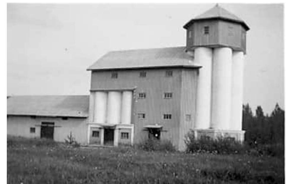
1933 perustettu Osakeyhtiö Laatuvilja rakensi Nummelan asemalta vuokraamalleen alueelle viljasiilon, josta tuli yksi Nummelan huomattavimpia rakennuksia. Laatuviljan siilosto Asematien varressa. Kuva: Viljo Mannström https://www.nummela.info/
