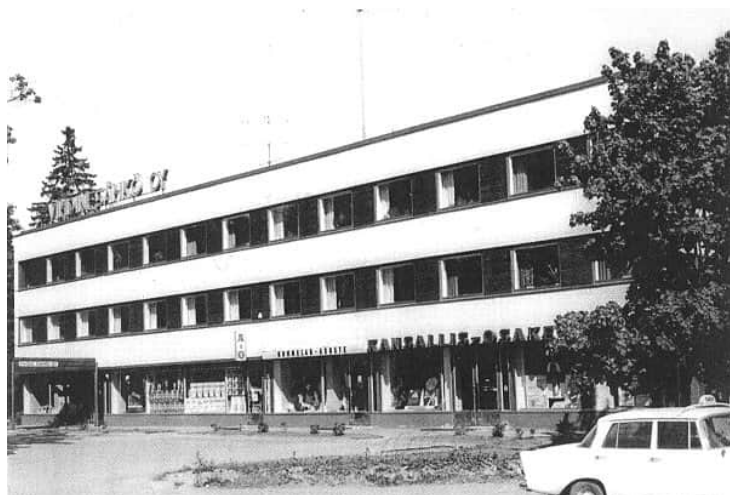
Vihdin Sähköyhtiön uusi toimitalo valmistui vuonna 1965 Vihdintie 1 tontille. Rakennuksessa toimi alkuun Sähköyhtiön myymälän ohella mm pankki (KOP) ja asuste-liike. Ylemmät kerrokset olivat asuinkäytössä, lisäksi talossa oli seurakunnan ja marttojen yhdistystiloja. Kuva https://www.nummela.info/
