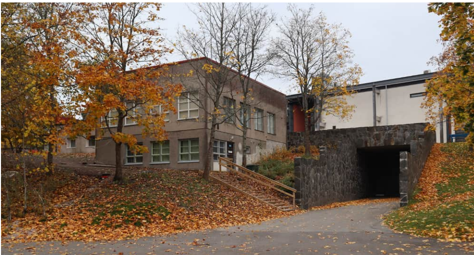
1928 rakennettu autokorjaamo, toiminut myöhemmin paloasemana, nykyään galleriatilana ja opistokäytössä.
