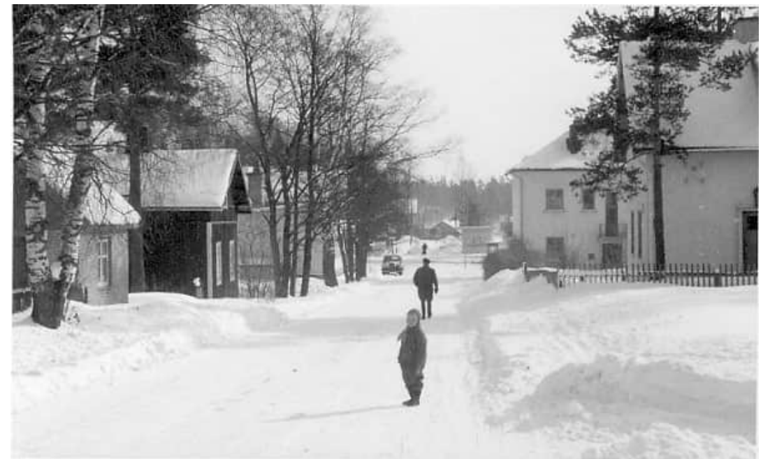
Talvinen näkymä entiseltä Haapakyläntieltä (nykyinen Sentraalipolku) kohti Keskipistettä. Tien oikealla puolella taustalla näkyy Eroittajan kivitalo ja sen edessä 1949 valmistunut omakotitalo. Tien vasemmalla puolella puiden peittämänä on Vison ravintola, Vison teurastamorakennuksen pääty sekä nykyisen Torikeskuksen (entisen Harjunsyrjän) alueella ollut leipomorakennus. Kuva: Viljo Mannström https://www.nummela.info/
