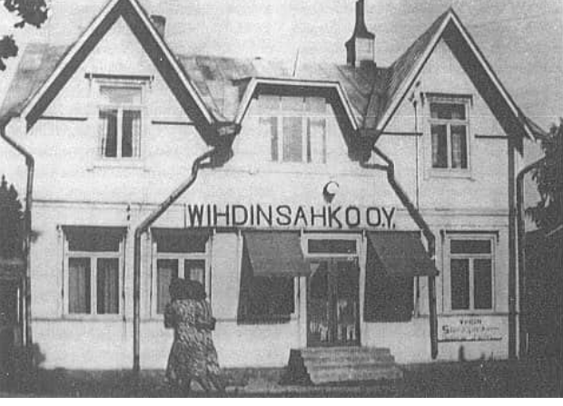
Vesalan talo 1920-luvulla. Julkisivun parveke on poissa ja yläkertaa on muutenkin muutettu. Kuva Vihdin Sähköyhtiön historiikista.
