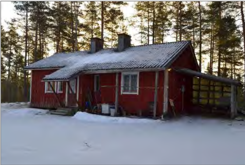
Kuva 18. Asuinrakennus pohjoissivulta. Ikkunat ja ovet lienevät alkuperäiset.
