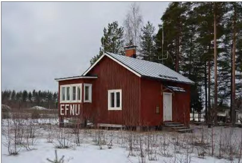
Kuva 20. Rakennus kuvattuna koilliskulmalta.
