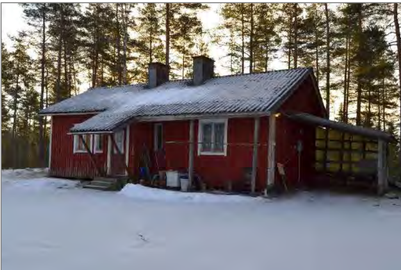
Kuva 18. Asuinrakennus pohjoissivulta. Ikkunat ja ovet lienevät alkuperäiset.
