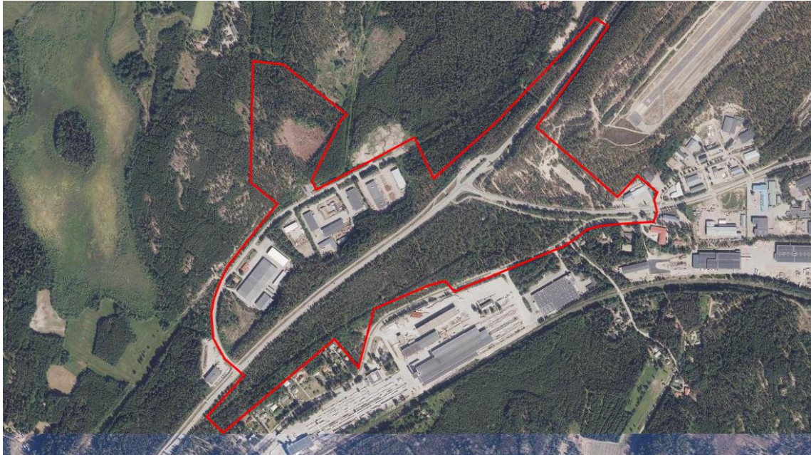
Kuva 3. Suunnittelualan rakennuskanta koostuu pääosin teollisuusrakennuksista. Kehätien ympärillä on paljon metsäaluetta. (MML, 2025)
