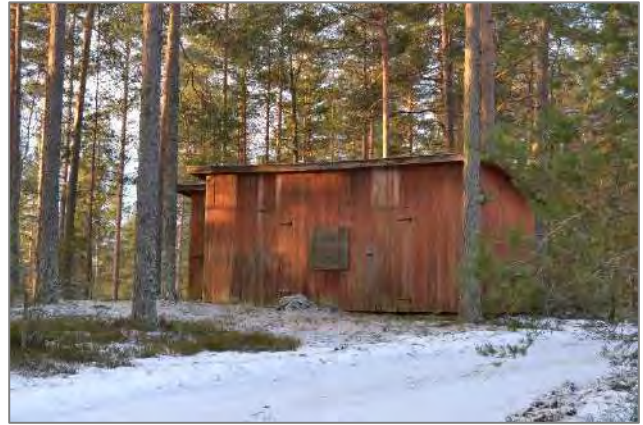
Kuva 17. Asuinrakennuksen länsipuolinen piharakennus.
