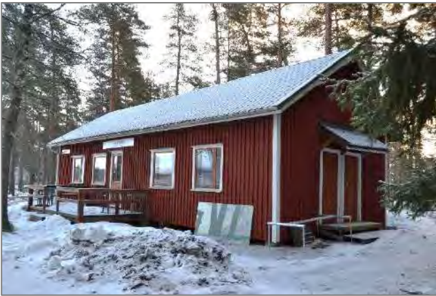
Kuva 15. Entinen työparakki kuvattuna luoteiskulmalta.
