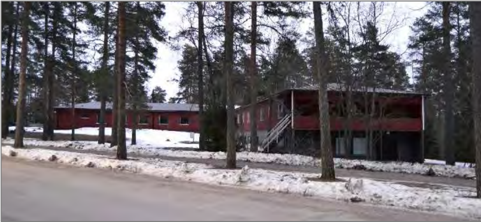
Kuva 30. Hotellirakennus kuvattuna Lentokentäntieltä. Vasemmalla toinen rakennusosa, oikealla kolmannen rakennusosan pääty. Molemmat laajennusosat ovat aumakattoisia, katteena on saumapelti.
