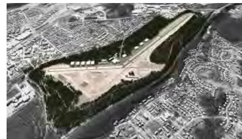
Alueen uudisrakentaminen sijoittuu lentokenttäalueen reunaan.
