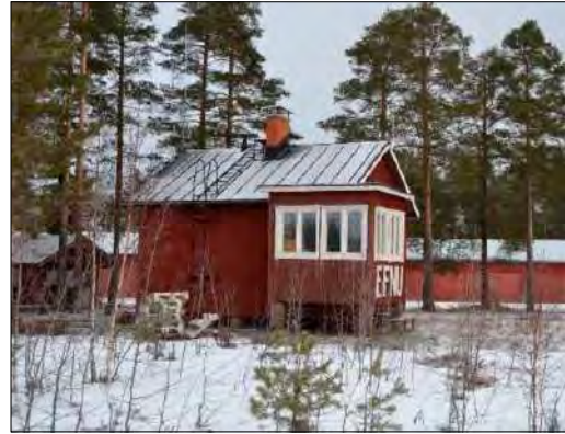
Vanha lennonjohtorakennus. Rakennusaika: 1930- ja 1940-lukujen taite.
