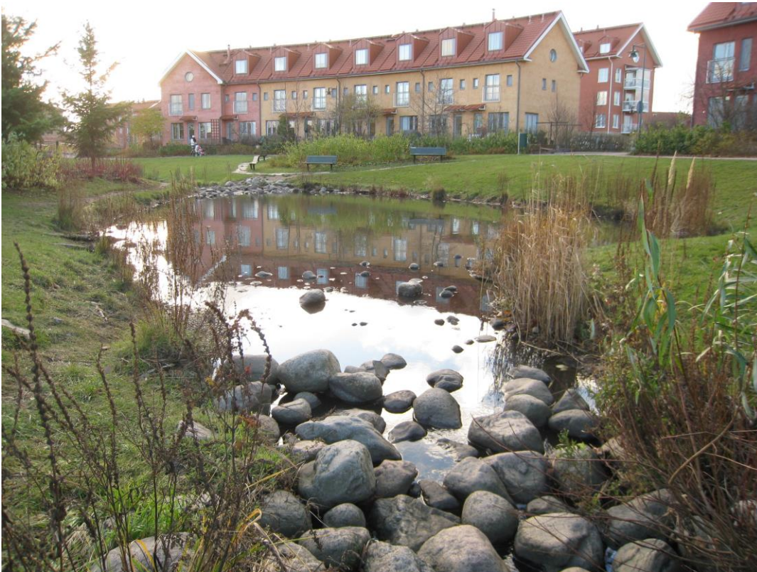
Kuva 7. Esimerkkikuva hulevesien viivytysaltaasta (Ilmastonkestävä kaupunki).
