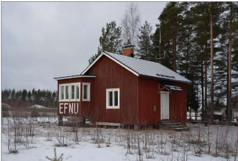
Kuva 20. Rakennus kuvattuna koilliskulmalta.
