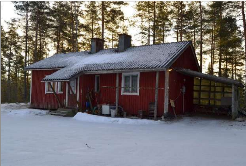
Kuva 18. Asuinrakennus pohjoissivulta. Ikkunat ja ovet lienevät alkuperäiset.
