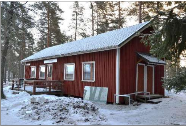
Kuva 15. Entinen työparakki kuvattuna luoteiskulmalta.
