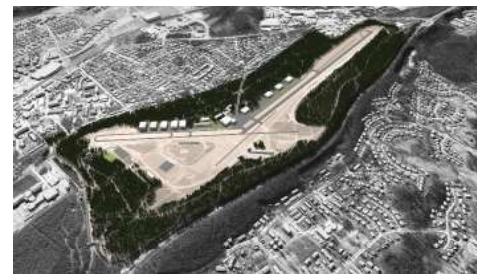
Alueen uudisrakentaminen sijoittuu lentokenttäalueen reunaan.
