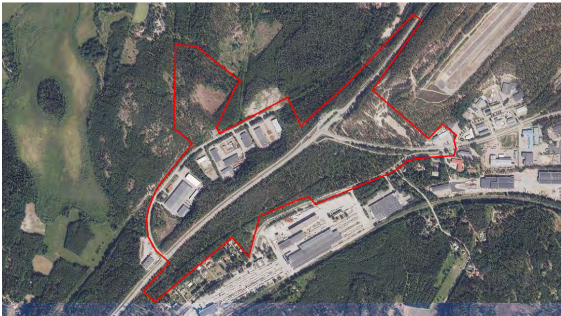
Kuva 3. Suunnittelualueen rakennuskanta koostuu pääosin teollisuusrakennuksista. Kehätien ympärillä on paljon metsäalueita. (MML, 2025)
