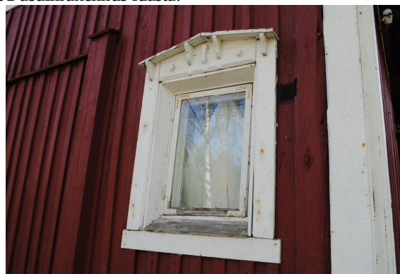
Asuinrakennuksen eteisen ikkunapuitteet.
