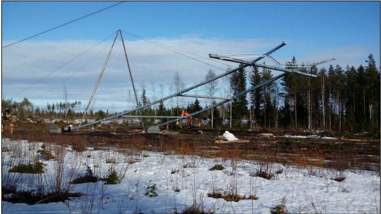
Kuva 3-7. Voimajohtopylvään pystytys.
