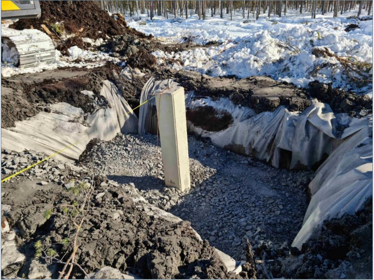
Kuva 3-4. Pylvään perustuselementin asentaminen.
