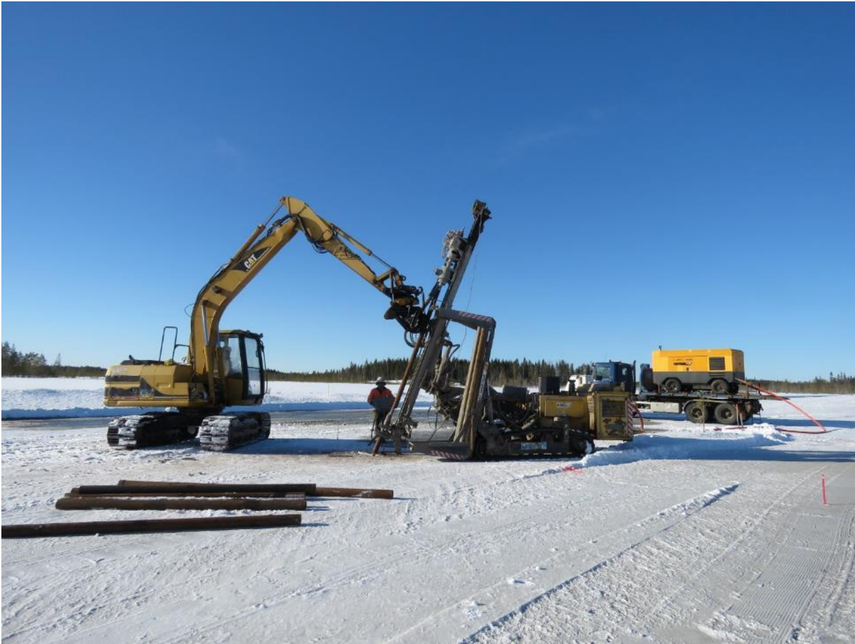
Kuva 3-6. Porapaaluperustuksen tekoa suoalueella, jossa työalue on jäädytetty.
