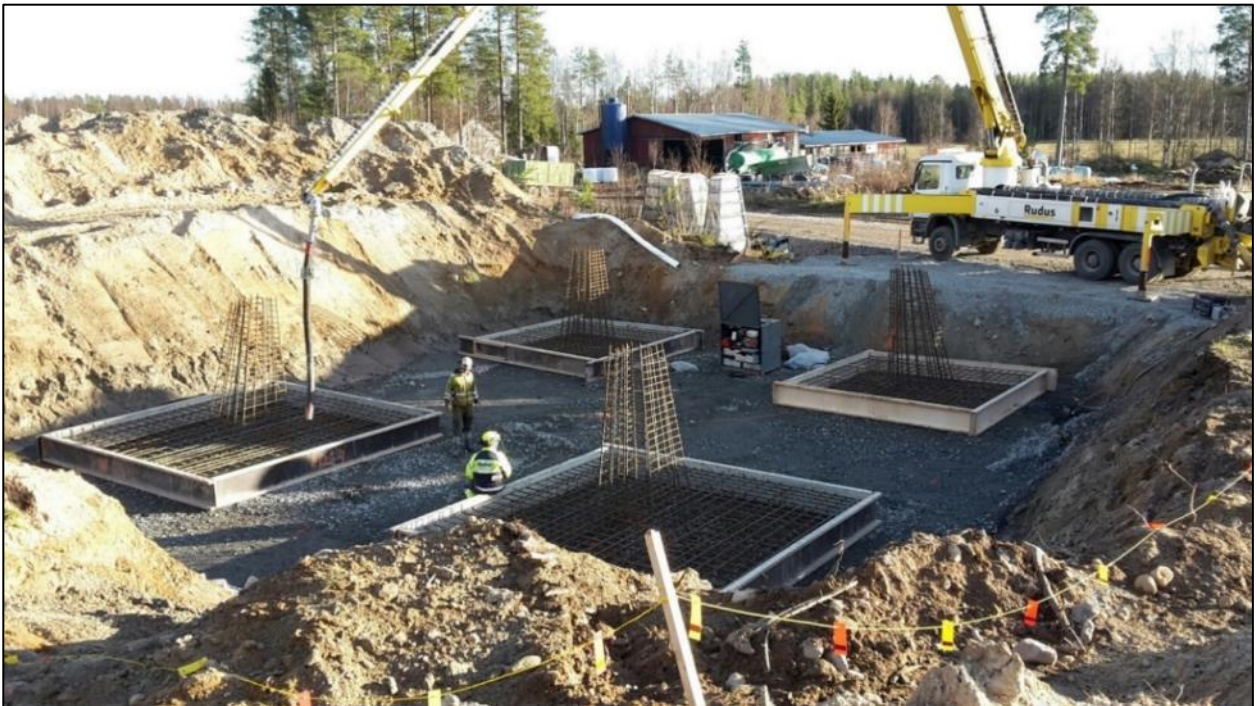
Kuva 3-5. Vapaasti seisovan pylvään perustuksen pohjatöitä.
