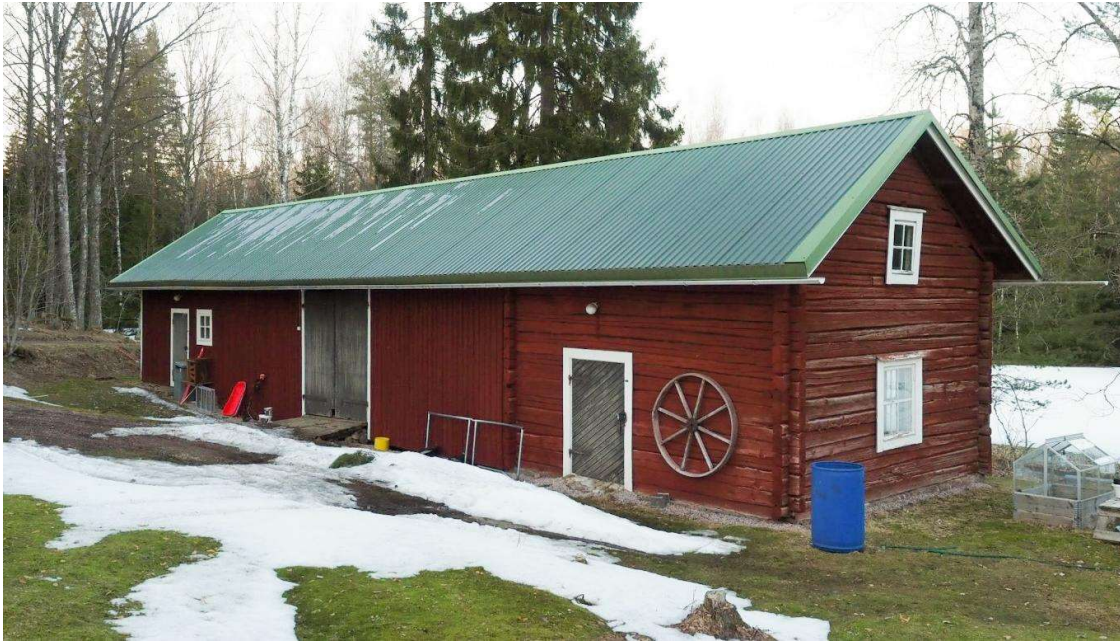
Kuva 10. Vanha navettarakennus (indeksikartassa nro 2)
