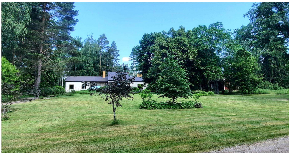
Kuva 9. Vasemmalla Soiniemen 1950-luvun alussa rakennettu ja Heikki Sirenin suunnittelema päärakennus (indeksikartassa nro 1) ja oikealla kasvillisuuden takana yksi lomarakennuksista
