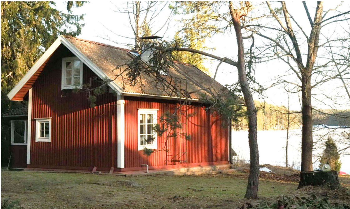
Kuva 11. Loma-asuntokäytössä oleva vanha torpan päärakennus (indeksikartassa nro 3)
