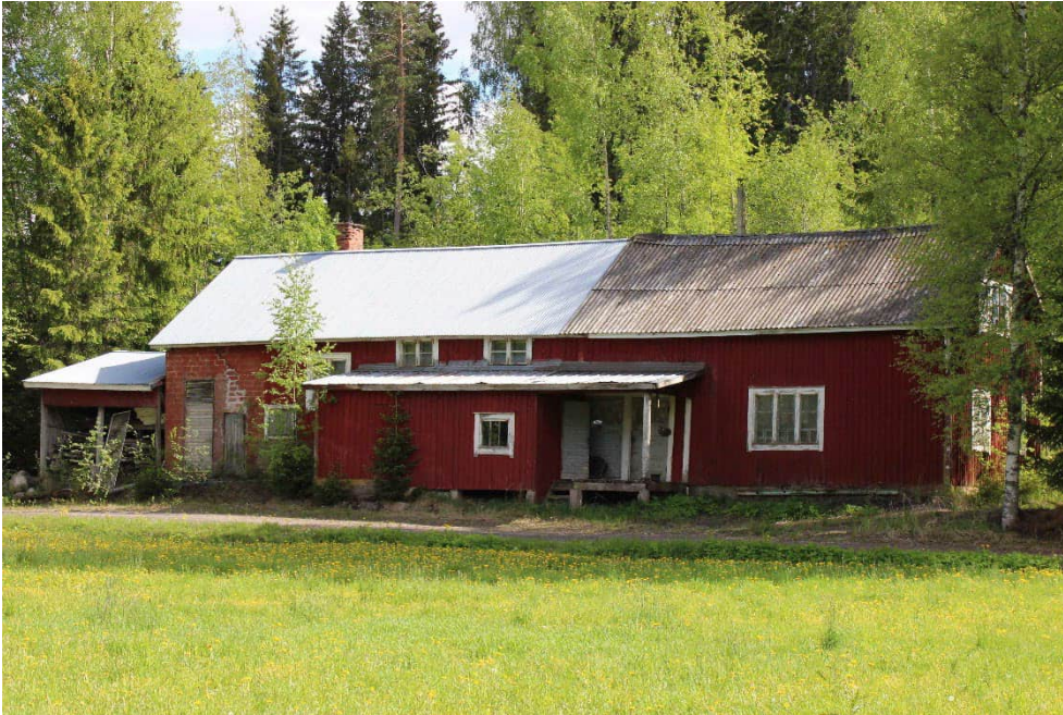
Kuva 28 Väinölän puusepänverstaan rakennus.
