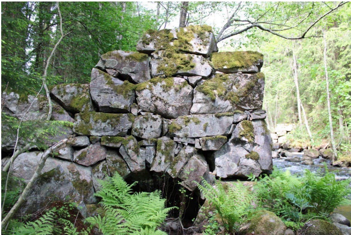
Kuva 24 Haukojan myllyn kivijalan rauniot. Myllyn puurakenteet ovat lahonneet jo satakunta vuotta sitten.
