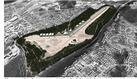
Alueen uudisrakentaminen sijoittuu lentokenttäalueen reunaan.
