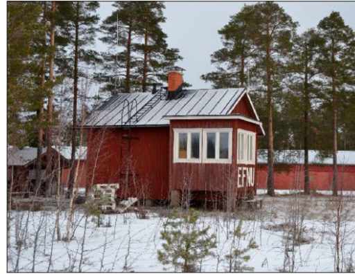
Vanha lennonjohtorakennus. Rakennusaika: 1930- ja 1940-lukujen taite.
