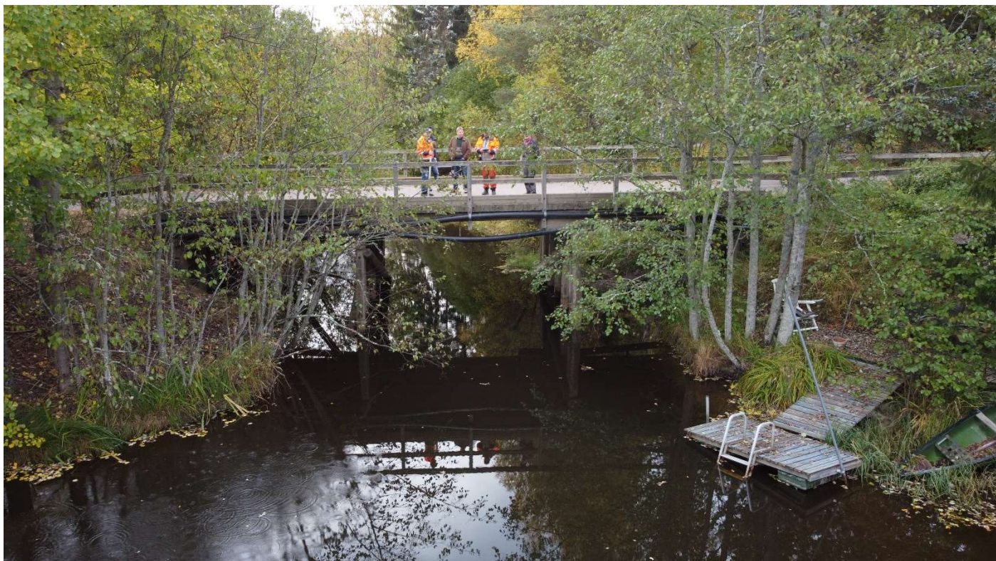
Kuva 7. Yleiskuva sillan sivulta.
