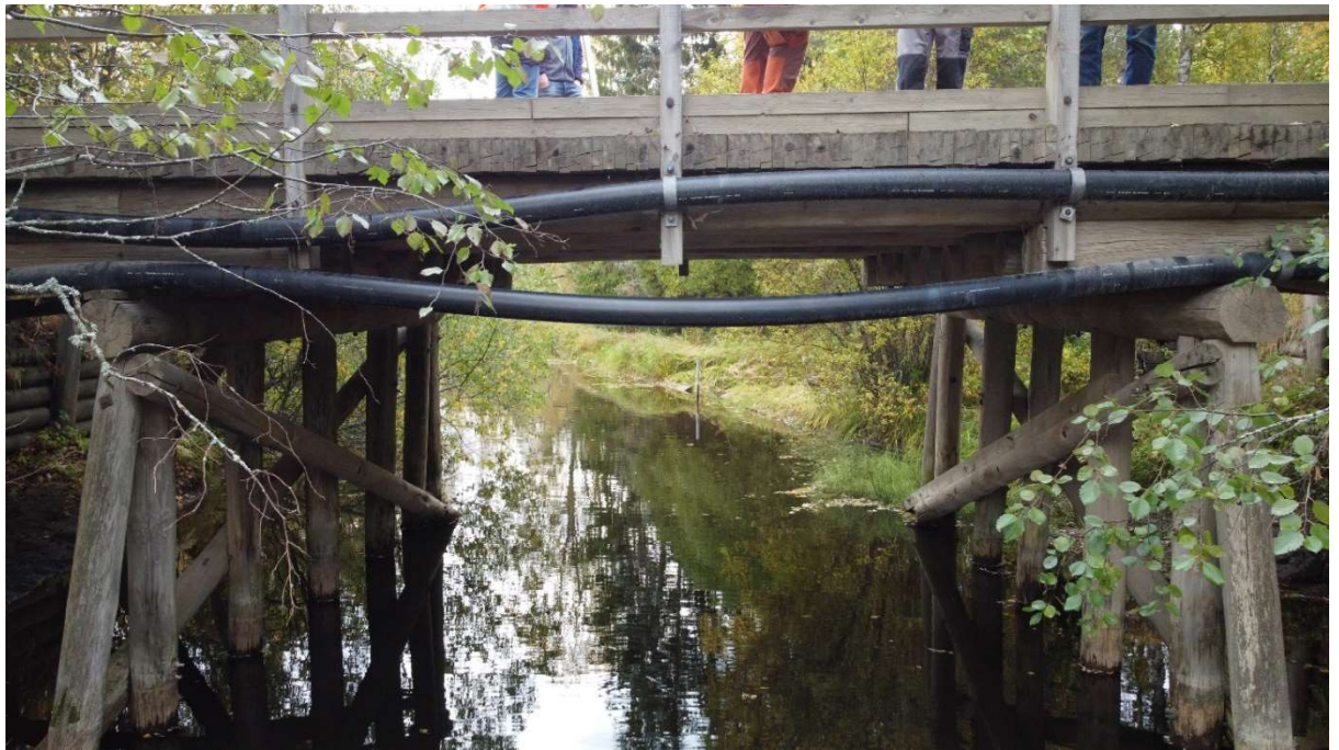
Kuva 2 Sähkökaapeli Vihtiöen sillassa.
