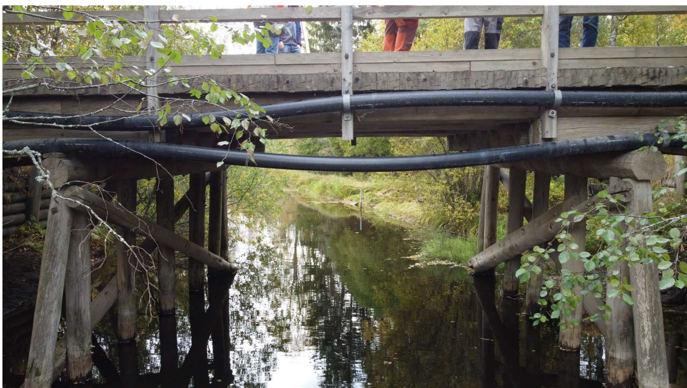
Kuva 8. Sillan puiset rakenteet.
