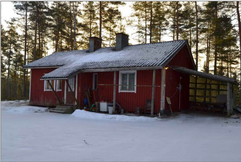
Kuva 18. Asuinrakennus pohjoissivulta. Ikkunat ja ovet lienevät alkuperäiset.
