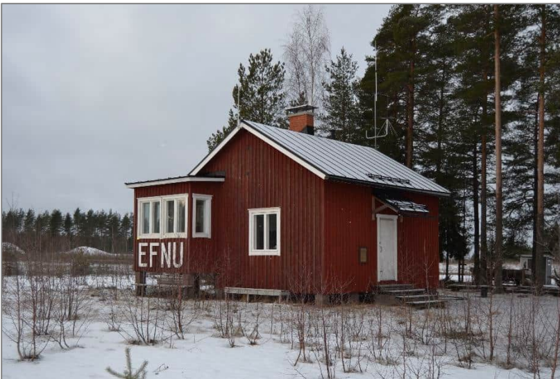
Kuva 20. Rakennus kuvattuna koilliskulmalta.
