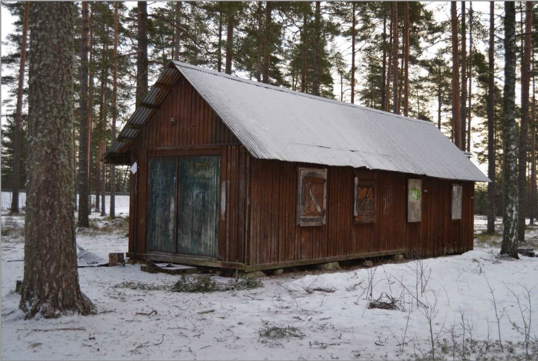
Kuva 21. Rakennuksen läntinen pääty (kuvassa vasemmalla) on rakennettu ensin ja itäinen pääty vuoden 1941 jälkeen. Vasemmanpuoleisin ikkuna toimi aikoinaan kanttiin myyntiluukkuna. (Peltonen 2013, s. 55.)
