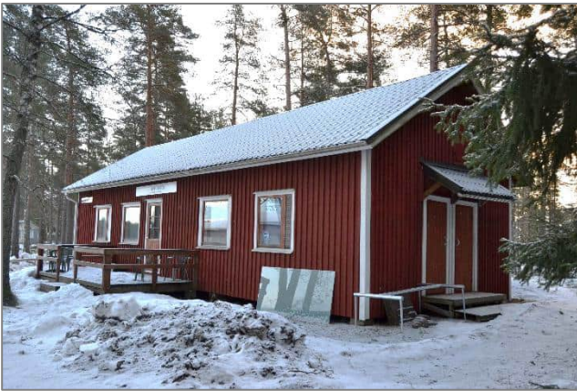
Kuva 15. Entinen työparakki kuvattuna luoteiskulmalta.
