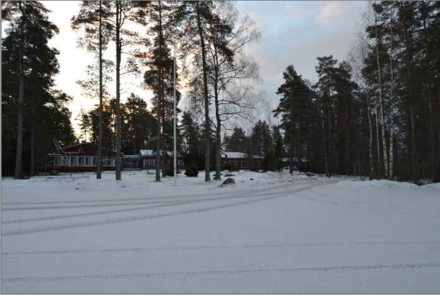
Kuva 7. Air Hotellin rakennus kuvattuna parkkialueelta, lentokentän ja hotellin välistä.
