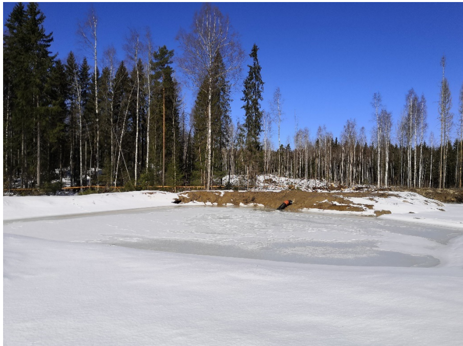
Kuva 4. Uusi laskeutusallas. Ylivuotoputki nähtävissä altaan takana.
