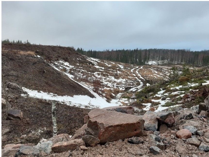
Kuva 6. Maanvastaanottoalueen laajennusosaa. Vasemmalla näkyy vanhan läjitysalueen reuna.
