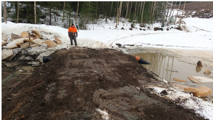
Kuva 11. Ylivuotoputken asennus valmiina 17.1.2023.
