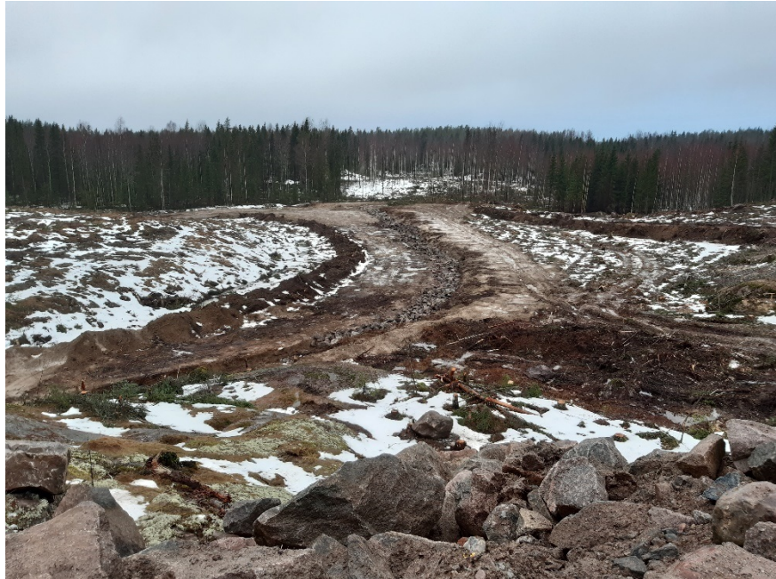
Kuva 8. Kuvan keskellä näkyy louheesta tehtyä salaojaa, joka johtaa uusiin vesienkäsittelyaltilaisiin. Taustalta oli kaadettu varttuneita kuusia. Avohakkuuta maavastaanottoaikan ulkopuolisilla alueilla ei oltu tehty.
