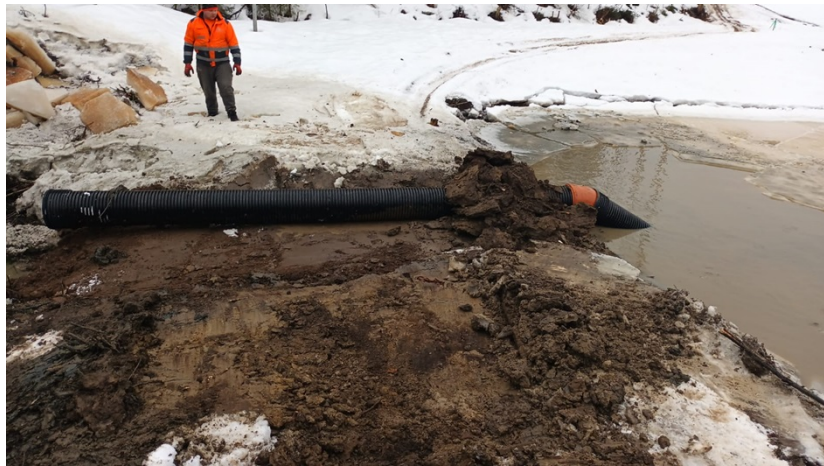
Kuva 10. Ylivuotoputken asennus vanhaan laskeutusaltaaseen 17.1.2023.
