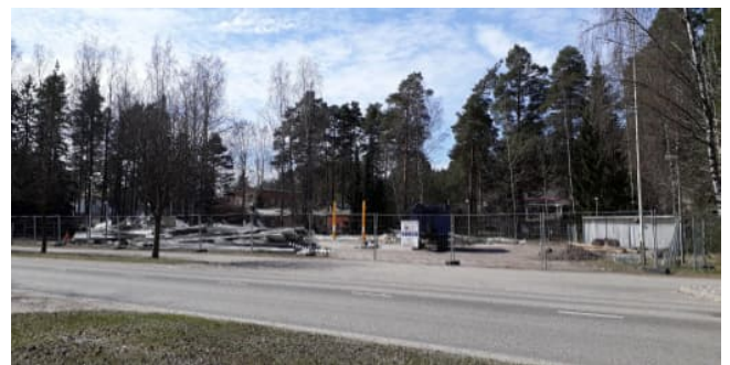
Huoltoaseman purkutytöt. © Vihdin kunta
