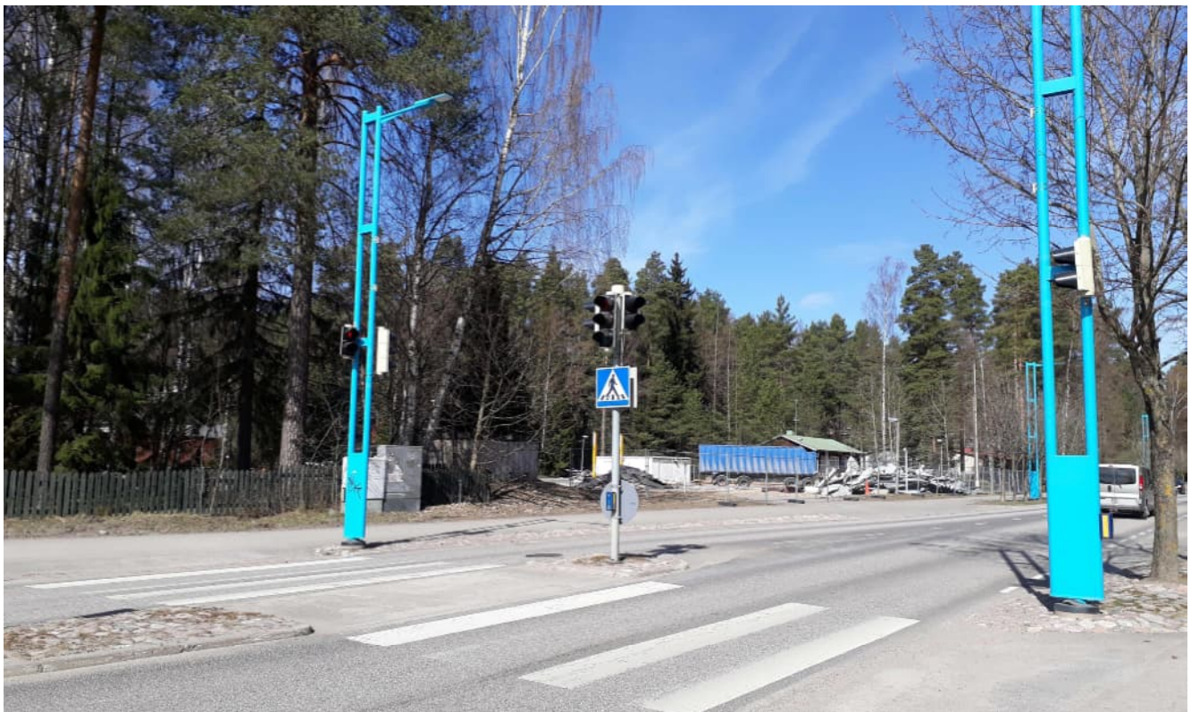
Kuva kaavamuutosalueesta Vihdintien ja Lohjantien risteyksestä otettuna. Kuva on otettu huhtikuussa 2021. Nesteen huoltoaseman purkutyöt ovat käynnissä. © Vihdin kunta.
