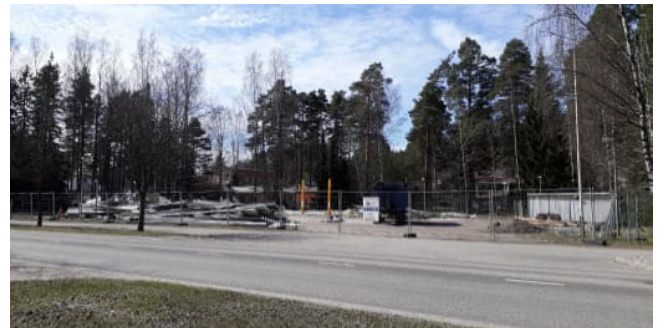
Huoltoaseman purkutöitä. © Vihdin kunta
