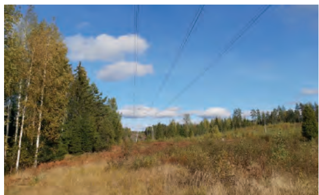
Suunnittelualueetta halkovat sekä 110 kV että 400 kV voimalinjat.
