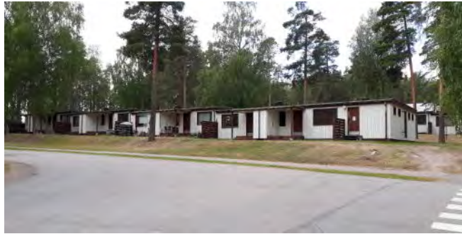
Yksikerroksiset rakennukset Nummenselkä -kadun suunnalta.
