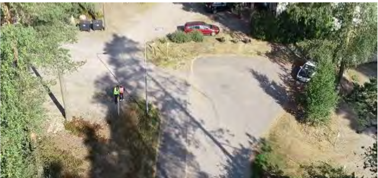
Nykytilanne Nummenjuuhu -kadun kääntöpaikan alueella. Kuvassa vasemmalla sijaitsee ajoyhteys viereiselle korttelialueelle. © Vihdin kunnan mittauslaitos
