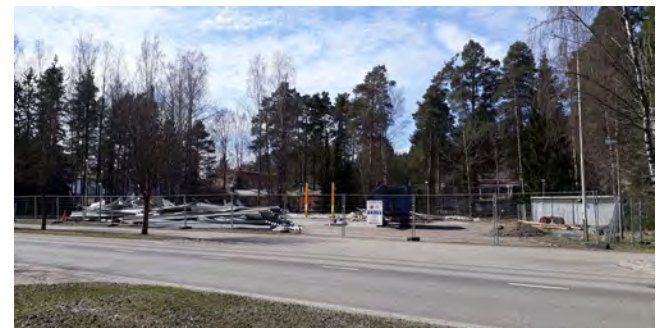
Huoltoaseman purkutyöt. © Vihdin kunta
