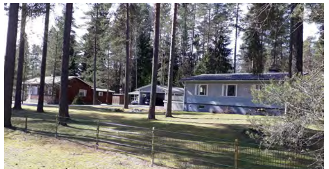
Kaavamuutosalueella sijaitseva rakentaminen. © Vihdin kunta
