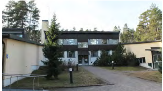
Yllä olevat valokuvat Palman rakennuksesta.
